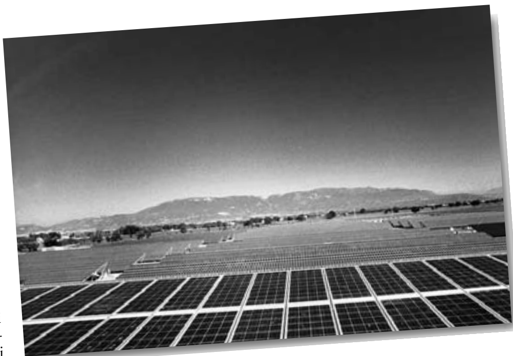
Una centrale fotovoltaica.
