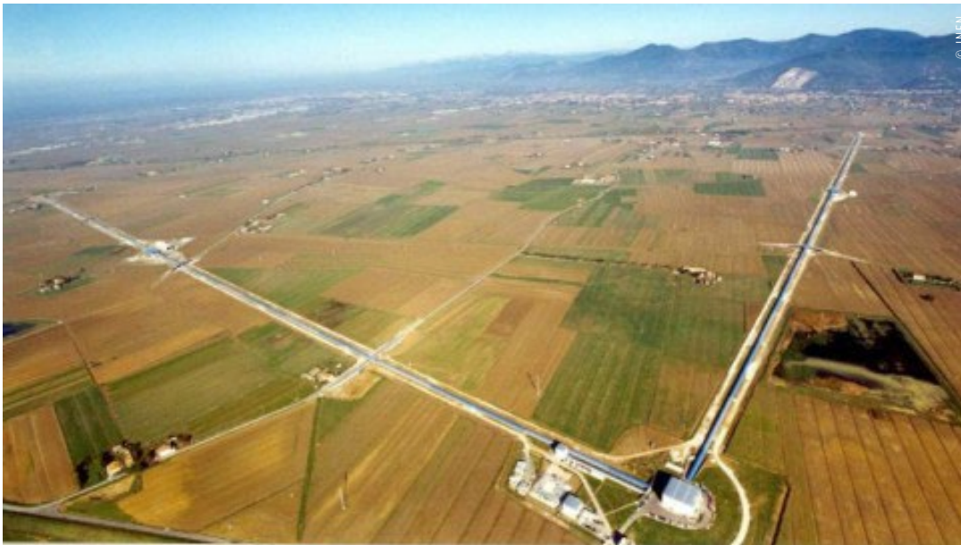
Foto aerea dell'area di Cascina (Pisa) dove è montato l'interferometro VIRGO. Si notano i due bracci da 3 km che si incontrano nel punto in cui è montato il rivelatore che misura l'interferenza dei due fasci di luce laser
