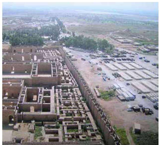
La ricostruzione saddamiana del palazzo sud di Nabucodonosor II; a destra, parte della base militare alleata (Figura 2).
